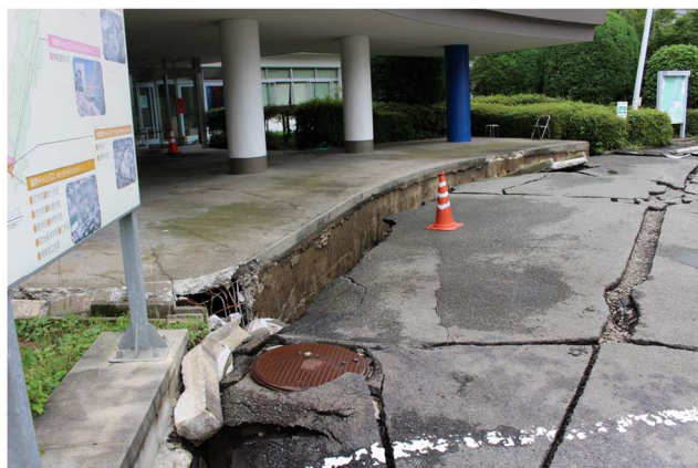
液状化、側方流動による地盤災害であった 校舎は耐震補強されており、倒壊するものはなかった
