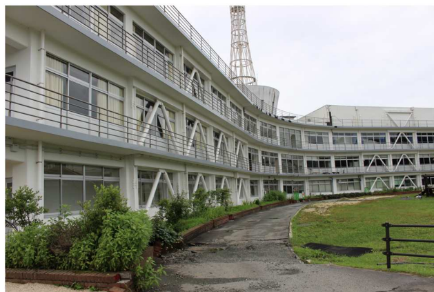
液状化、側方流動による地盤災害であった 校舎は耐震補強されており、倒壊するものはなかった
